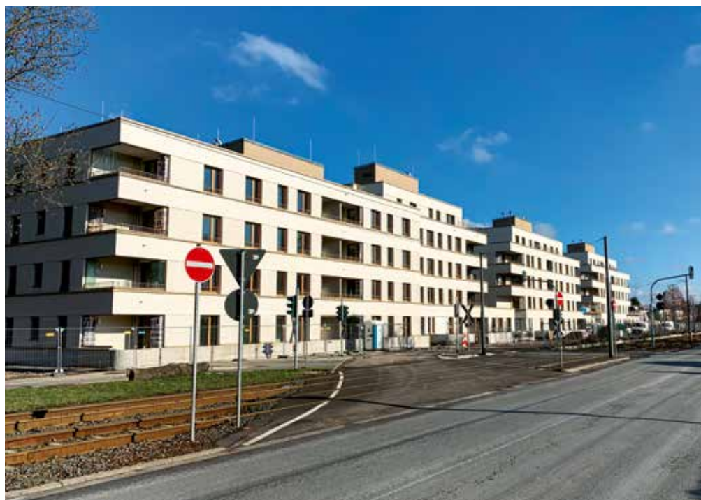
Erster Bauabschnitt in Nied entlang der Mainzer Landstraße.
