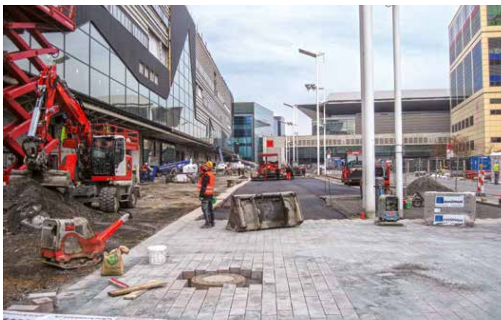
Die Außenanlagen vor der Messehalle 12 kurz vor Abschluss der Arbeiten.
