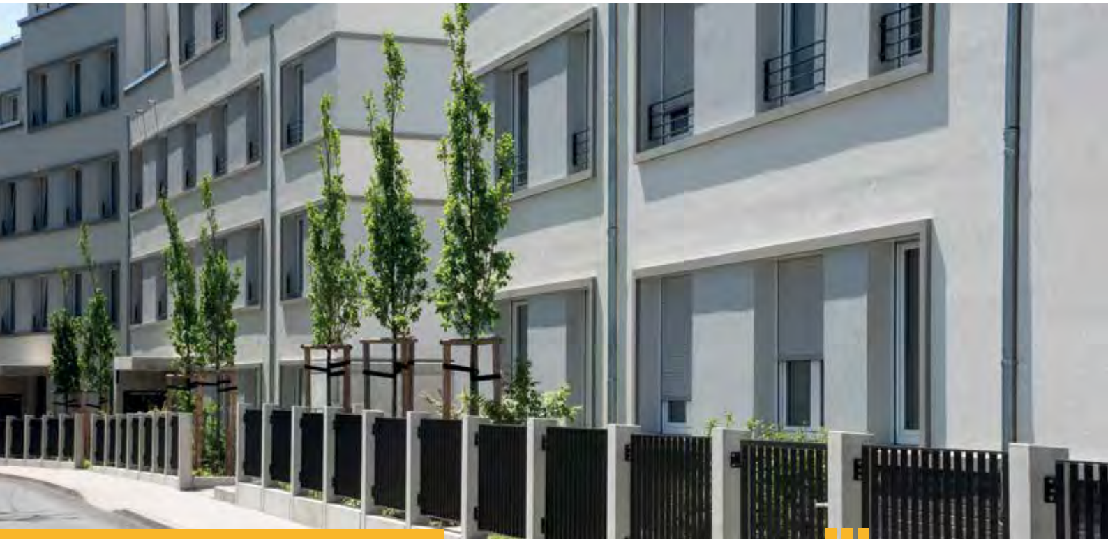
Kohlbrandstraße / Berger Straße Frankfurt am Main - Bornheim
