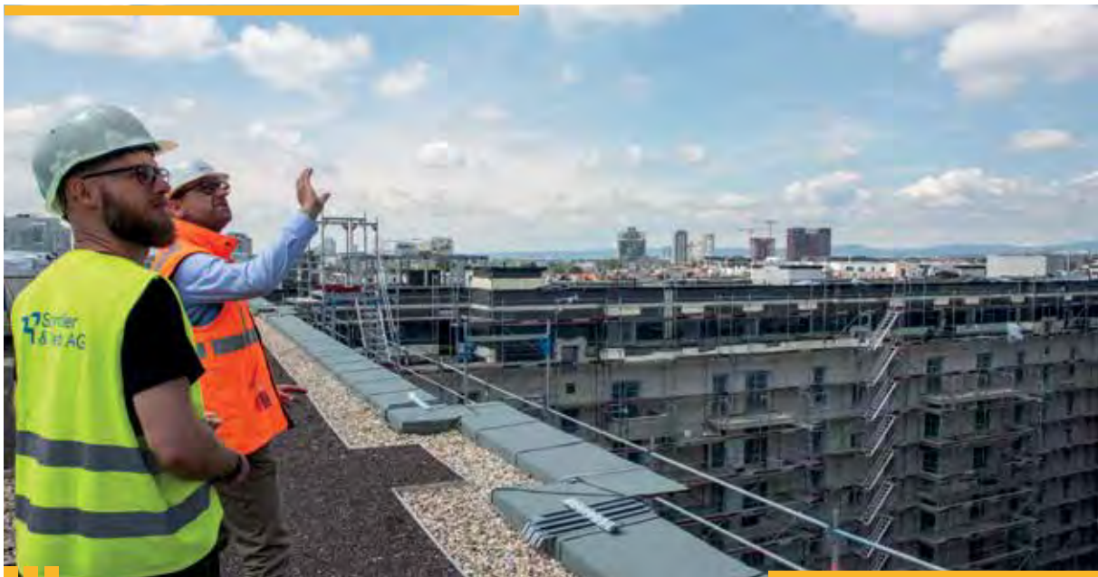
(v.l.n.r.: Philipp Zdrenka, Schindler & Werb AG, Bauüberwachung Thomas Ritter, ABG, Bauherrnvertreter
