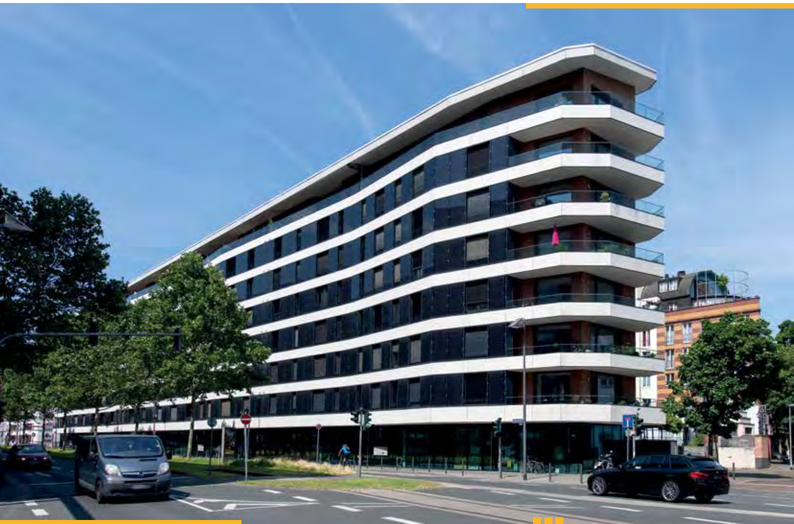
■ ■ ■ ■ Aktiv-Stadthaus, Speicherstraße Frankfurt am Main - Gutleutviertel
