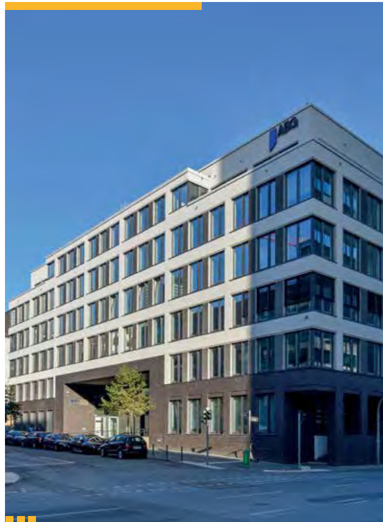
ServiceCenter Mitte - Konzernzentrale Frankfurt am Main - Gallusviertel
